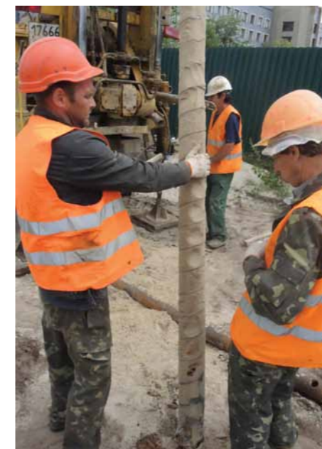
WIERCENIE GEOLOGICZNE NA TERENIE BADAŃ
